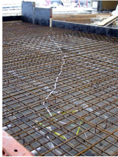
Rys 7. Ułożone zbrojenie lewego pasma płyty P1 z zainstalowaną rozetą
