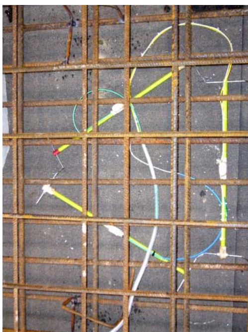
Rys. 4. Rozeta zainstalowana w miejscu oparcia kół podwozia głównego lewego
