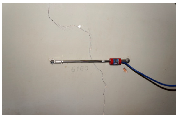
Rys. 12. Tensometr 6160 zainstalowany w hydroforni
