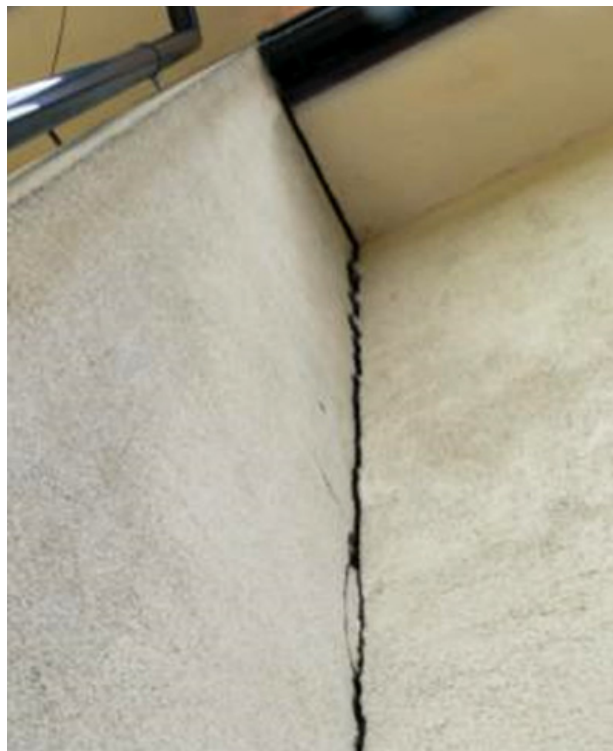
Rys. 4. Szczelina na elewacji budynku szkoły
