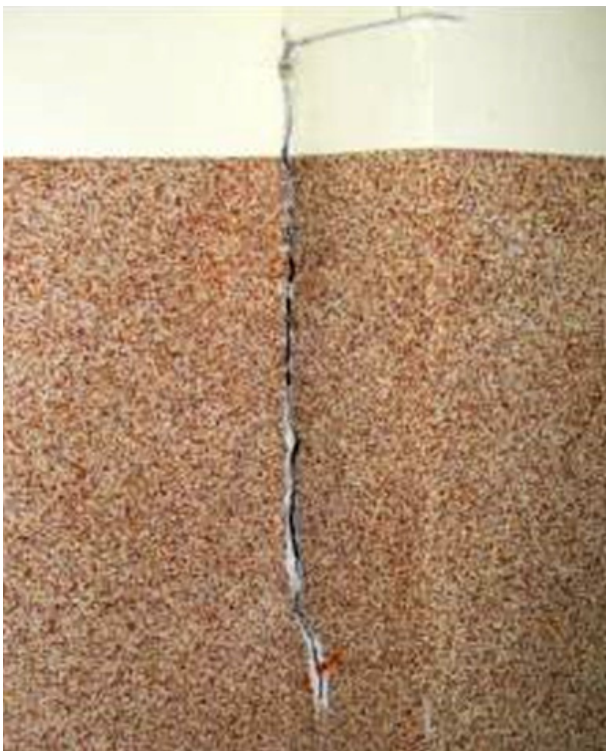
Rys. 3. Szczelina na ścianie wewnątrz budynku w miejscu łączenia się budynku właściwego i przewiązki
