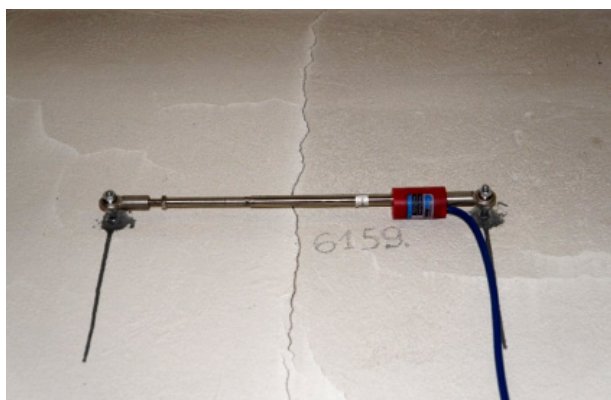
Rys. 9. Tensometr 6159 zainstalowany w hydroforni
