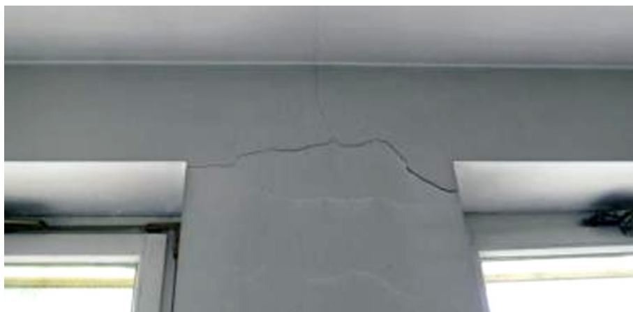
Rys. 2. Zarysowania na ścianie w kotłowni gazowej, przy narożniku południowo-wschodnim szkoły
