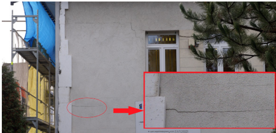
Rys. 1. Narożnik południowo-wschodni budynku szkoły
