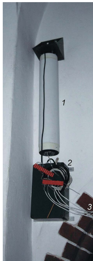
Rys. 8. Inklinometr 1 i telemetryczny miernik strunowy TMS-1 2 zainstalowane w wieży. 3 – kable do tensometrów
