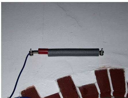
Rys. 5. Tensometr 4420 b zainstalowany na ścianie nad drzwiami od strony zakrystii
