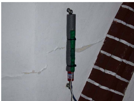
Rys. 4. Tensometr 4420 a i termometr zainstalowane na sklepieniu nad nawą boczną
