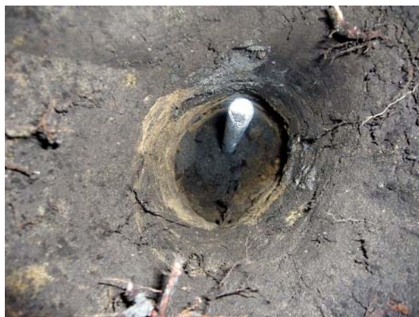
Rys. 7. Zabetonowana w otworze szpilka
