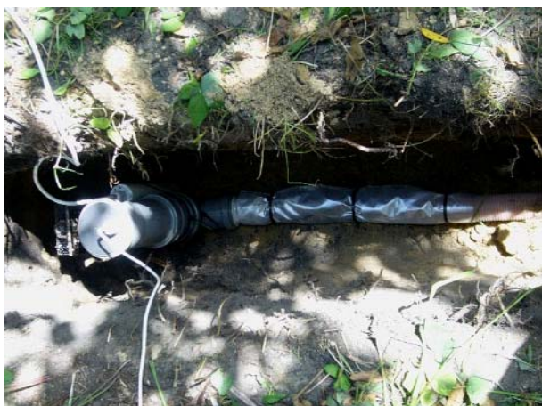
Rys. 8. Przetwornik przykręcony do szpilki
