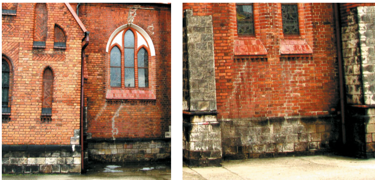
Rys. 18. Pęknięcia płyty zabezpieczającej oraz ścian kościoła
