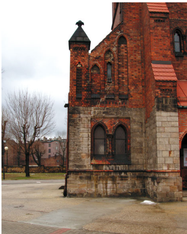
Rys. 8. Fragment płyty zabezpieczającej wokół kościoła z widoczną technologiczną przerwą dylatacyjną
