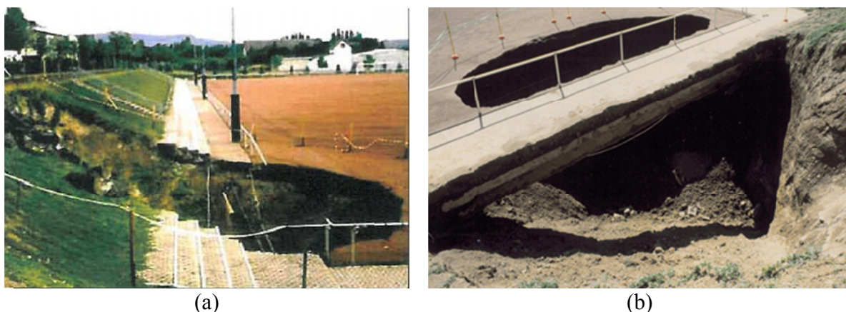
Rys. 6. Wielkośrednicowe zapadliska powierzchniowe powstałe nad zawalonymi komorami kopalni Oberer Niedemendiger Basaltlavastrom (obszar boiska sportowego) w mieście Mending [3] z lat: (a) 1988 oraz (b) 1994
