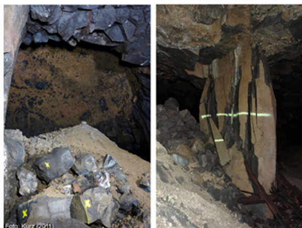
Rys. 5. Przykład zniszczonego filara oraz zawał skał stropowych [1]
