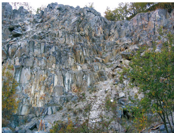
Rys. 1. Fragment badanej ściany skalnej w kopalni porfiru w Miękinii
