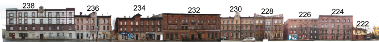
Rys. 1. Analizowane budynki przy ul. 1. Maja w Rudzie Śląskiej
