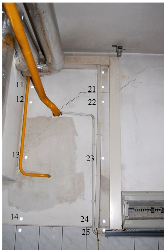
Rys. 5. Ścian wschodnia, rozmieszczenie punktów pomiarowych
