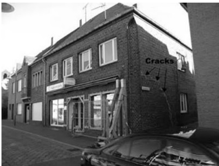
Rys. 13. Budynek zakwalifikowany do katastrofy budowlanej spowodowany nieregularnym wypiętrzeniem powierzchni terenu [Źródło: Heitfeld et al., 2006]
