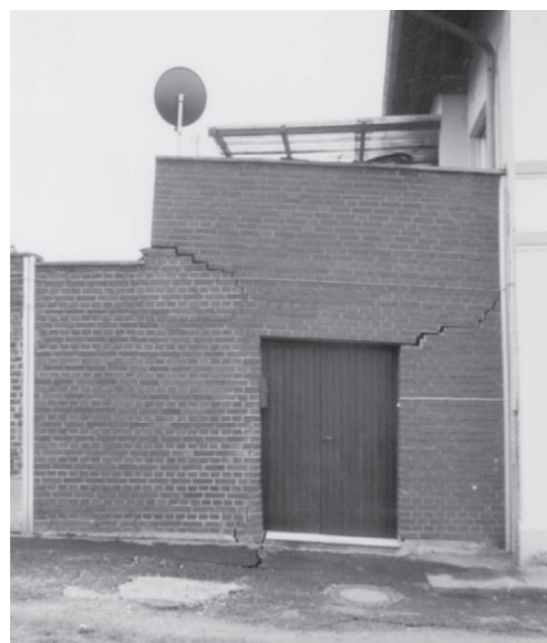
Rys. 15. Uszkodzenie na przybudówce budynku w Wessenberg [Źródło: Baglikow, 2003]
