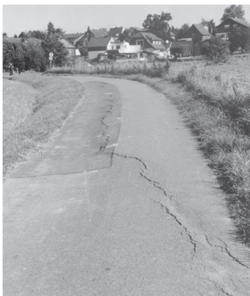
Rys. 14. Uszkodzenia w drodze lokalnej pomiędzy miejscowościami Vogelsang i Luchtenberg [Źródło: Baglikow, 2003]
