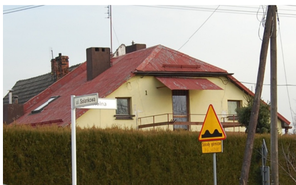
Fot. 4. Brak właściwego odprowadzenia wód z półszczytu dachu budynku
