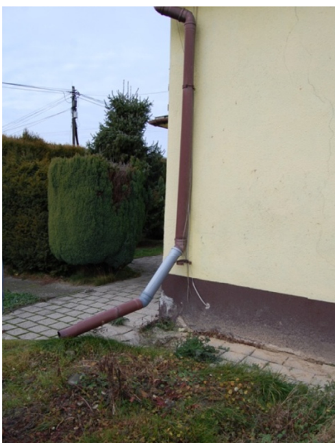
Fot. 3. Wyprowadzenie rury spustowej bezpośrednio na teren posesji
