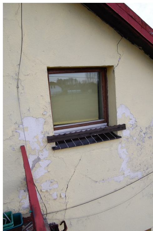
Fot. 6. Spękanie ściany nad powiększonym otworem okiennym
