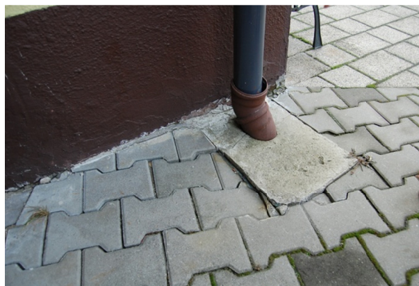
Fot. 2. Widoczne zapadanie się nawierzchni nad strudzienką zbiorczą
