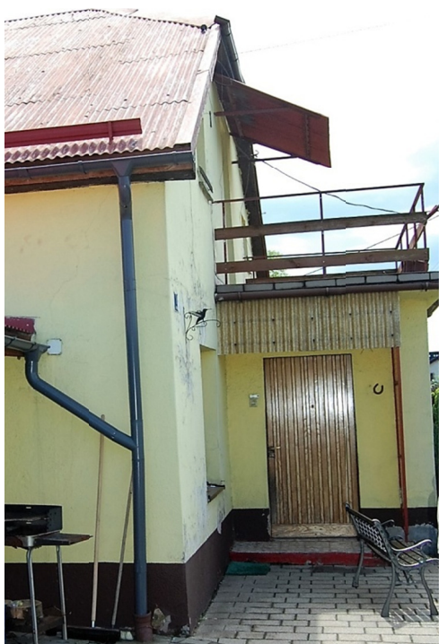
Fot. 1. Miejsce włączenia dodatkowego odpływu wód z połaci zadaszenia wiaty
