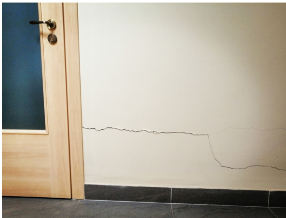
Rys. 4. Pęknięcie na ścianie w badanym obiekcie
