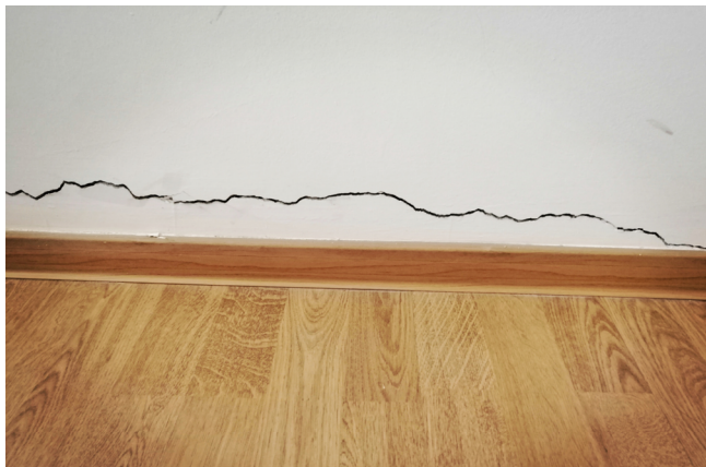
Rys. 5. Pęknięcie na ścianie w badanym obiekcie
