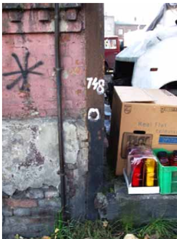
Rys. 7. Przykłady instalacji reperów na budynkach (Fot. L. Florkowska)
