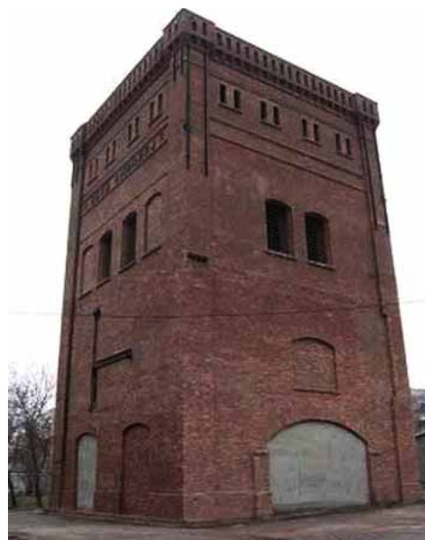
Rys. 2. Budynek nadszybowy dawnego szybu „Andrzej” („Aschenborn”) z 1870 r. ( http://www.mkzruda.pl/andrzej.htm )
