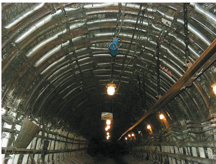
Fot. 2. Miejsce umieszczenia ultradźwiękowego anemometru stacjonarnego
