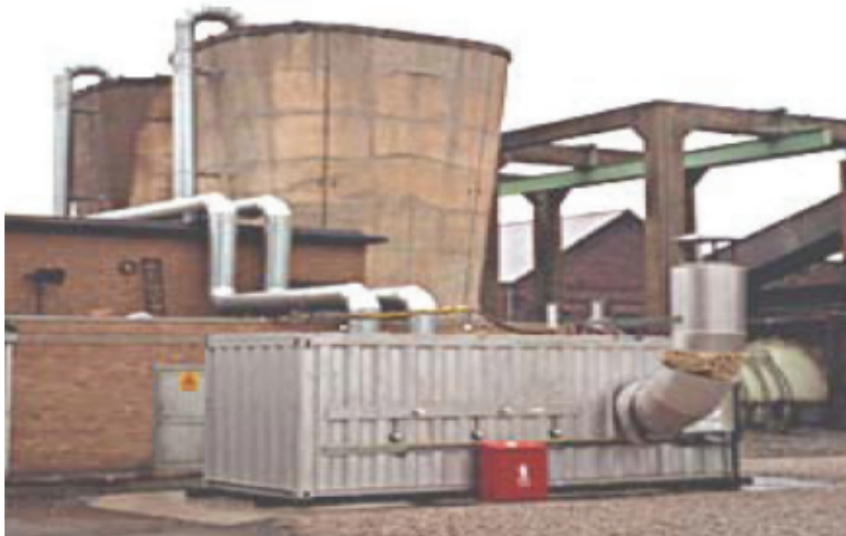
Rys. 2. Moduł VAM – Vocsidizer w kopalni Thorsby, Anglia [10]
